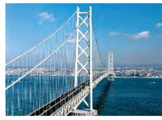
AKASHI KAIKYO: IN 1988, THE WORLD'S LONGEST SUSPENSION BRIDGE, THE AKASHI KAIKYO WAS DESIGNED TO WITHSTAND EARTHQUAKES AND WIND SPEEDS UP TO 180 MPH.
